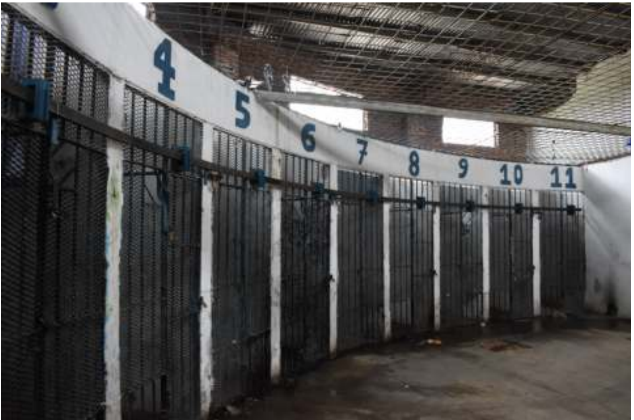
Sector aislamiento U2. Cárcel de Las Flores.
