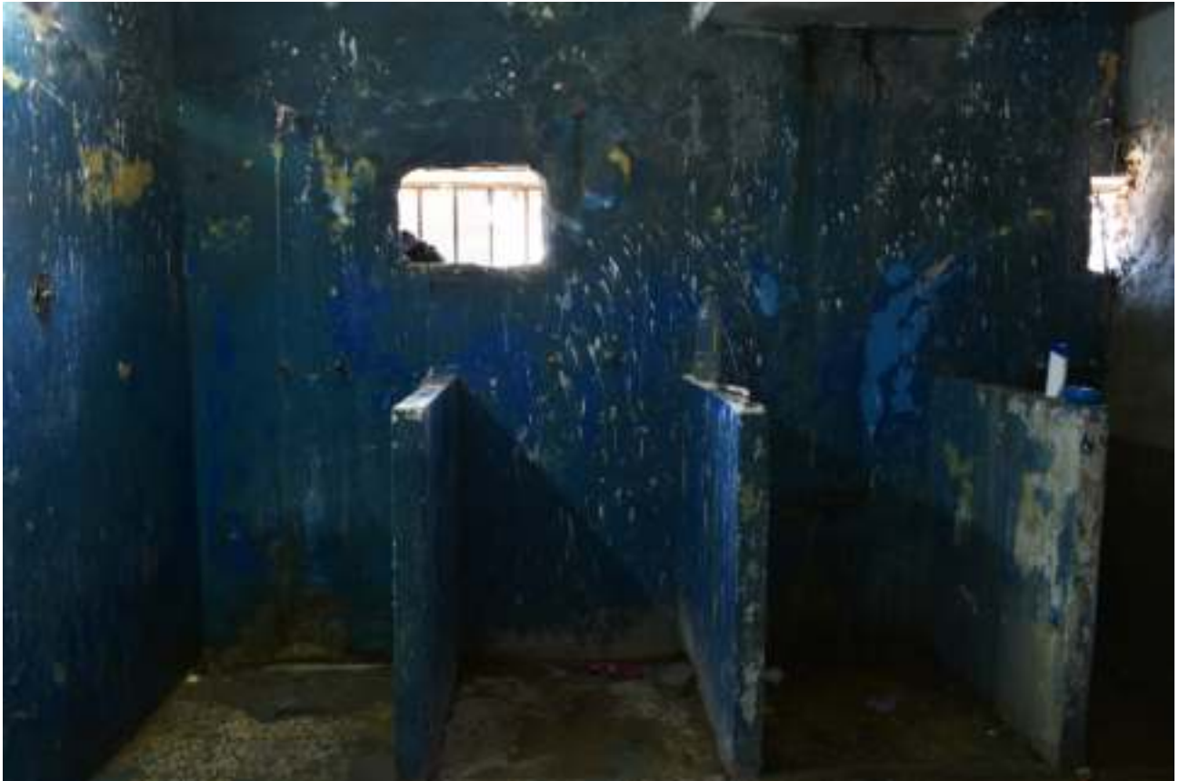
Duchas Pabellón 1. Cárcel de Las Flores.
