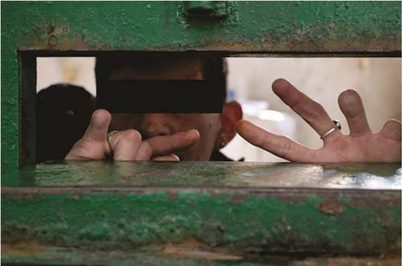
Autolesiones. Celda de aislamiento. Unidad I Coronda.
