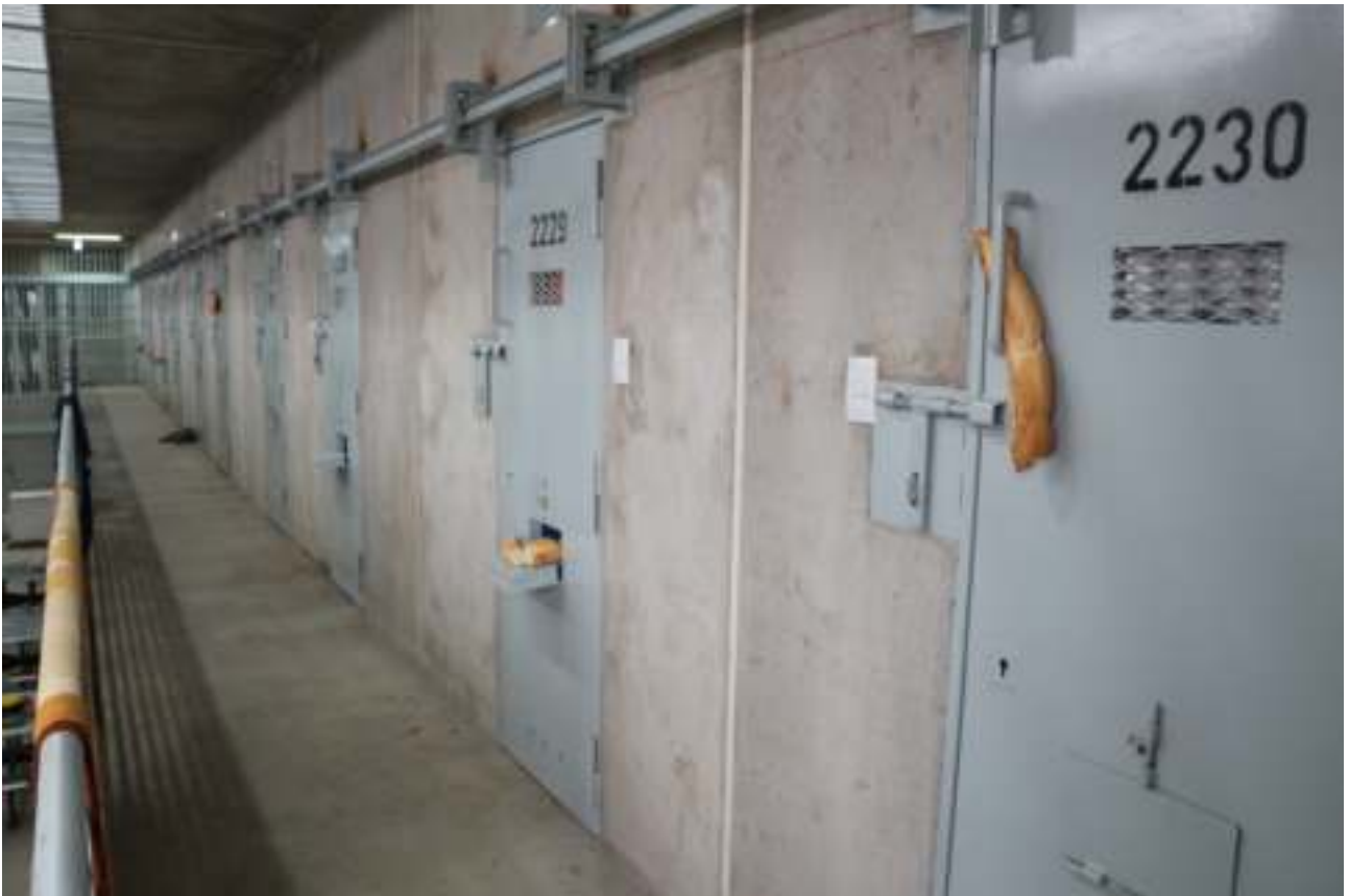
Interior del Pabellón.
