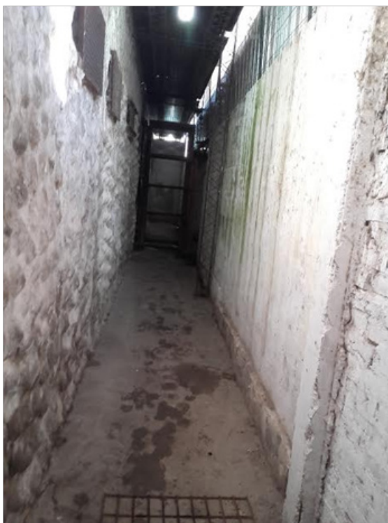
Foto Pasillo que conecta las celdas y el pabellón - Alcaidía Melincué
