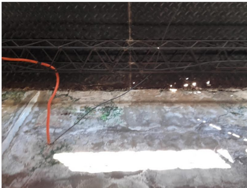
Foto Pasillo que conecta las celdas y el pabellón - Alcaidía Melincué
