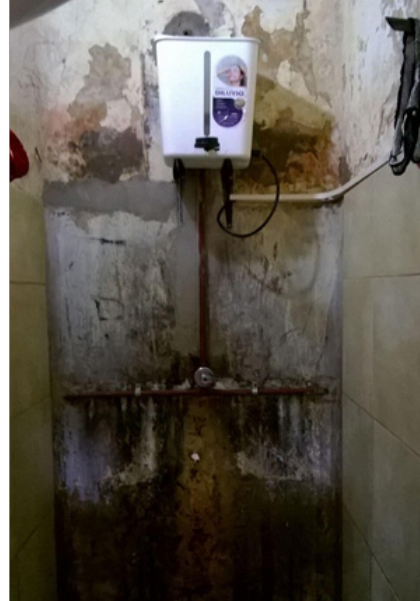
Foto ducha. Anexo estación de tránsito
